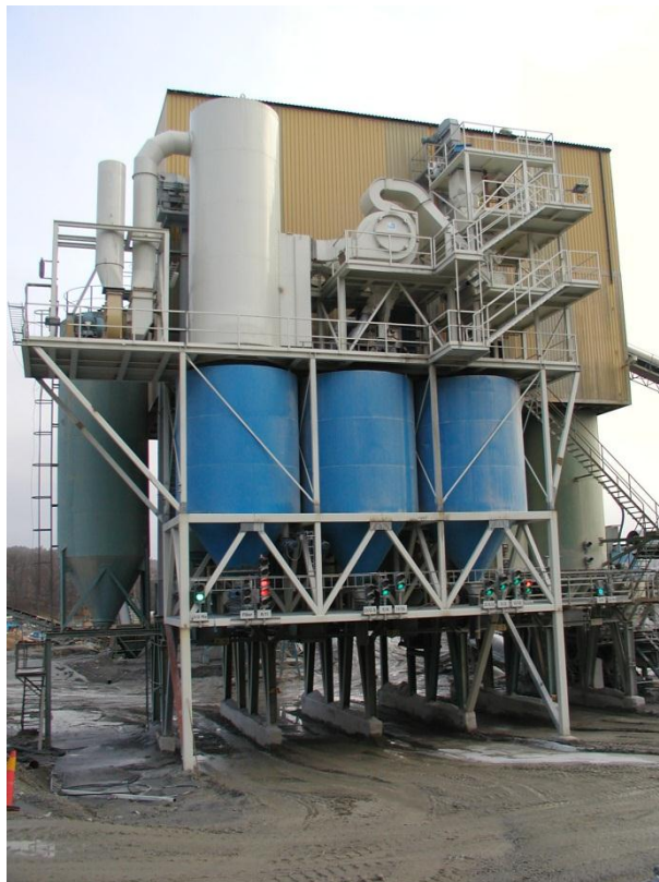
Figur 4 Installation av Buell vindsikt i NCC Stenungsund (foto: Pär Johnning)
